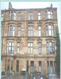
Tenement Flats (exc main door flats) 674 / 45%
