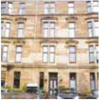
Tenement Flats (exc main door flats) 672, 45.2%
